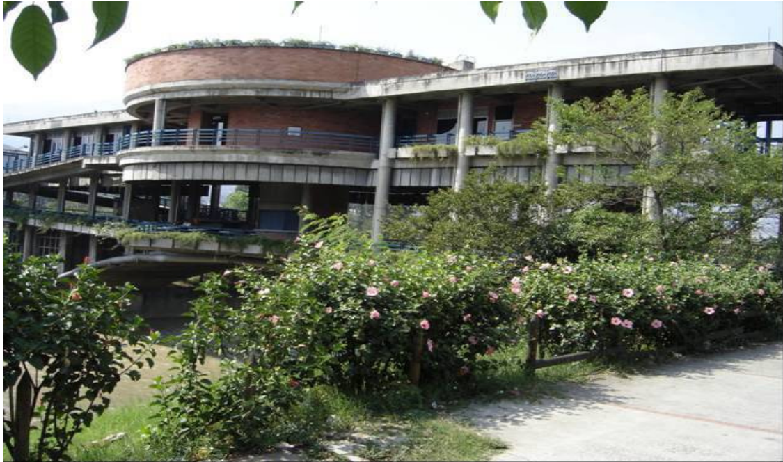
Foto 2. Infraestructura existente Aula Ambiental
