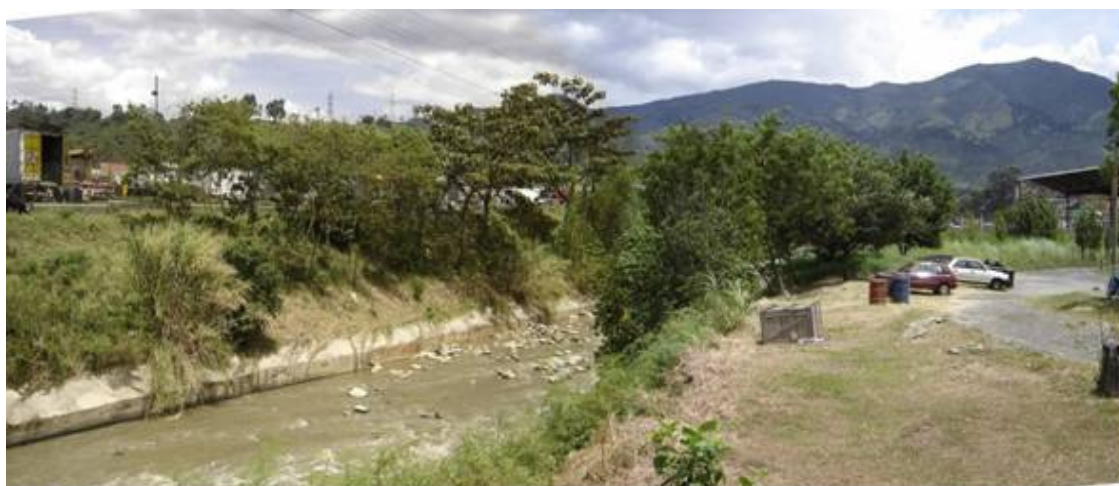
Foto 1 Panorámica ubicación y área a intervenir - Estación Ancón Sur
