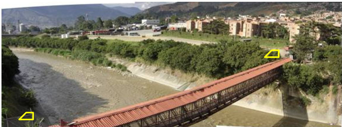
Foto 3. Panorámica Ubicación y área a intervenir - Estación Acevedo
